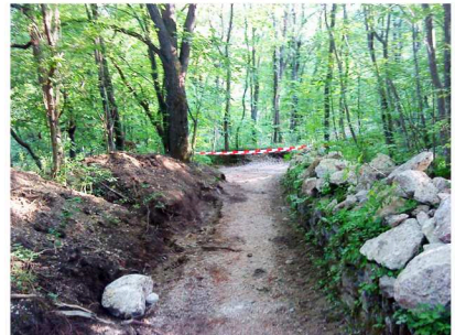
Ausgraben und Fundament.
