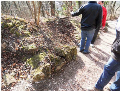
Besichtigung der alten Mauern.
